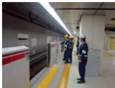
都営大江戸線可動式ホーム柵 保守点検作業
